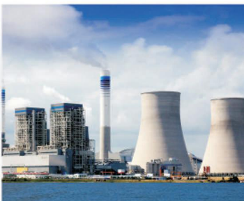
电力 ELECTRIC POWER
